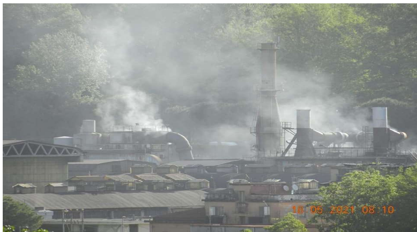
Fumi2021: "Una foto recente (maggio 2021) da cui si evince che i fumi emessi durante i processi di lavorazione non siano adeguatamente captati, ma fuoriescano in maniera incontrollata dai capannoni della Pisano"
